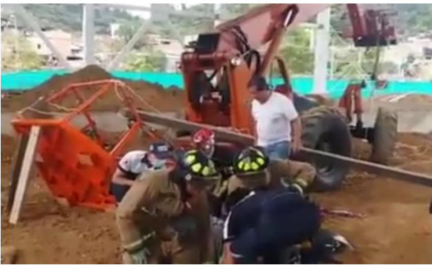
Rescate en estructura metálica y posterior traslado de 2 personas de sexo masculino que caen de 8 metros de altura, mientras realizaban labores en una obra sector de Pomona.
